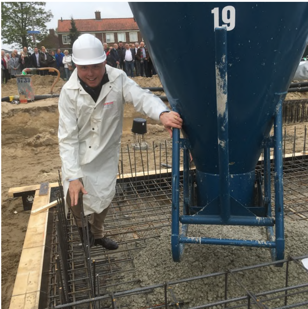
Wethouder Schalkwijk stort de betonvloer van het project Spatter-Fortuin
